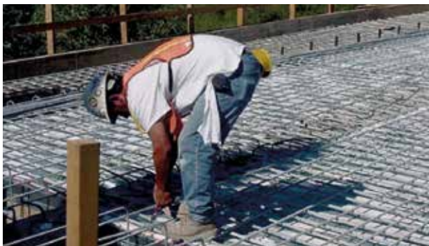
Kuva 10-15 Kuumasinkittyä raudoitusta sillassa.
