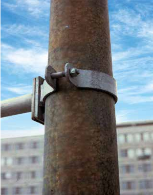
Kuva 10-2. Punaruskea värjäytyminen.
