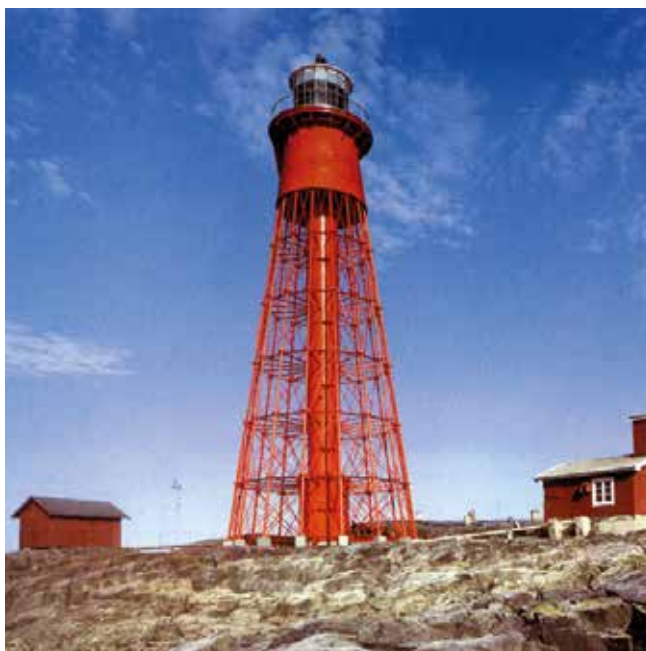
Kuva 11-1. Pater Noster -majakka on yksi Pohjoismaiden ensimmäisistä duplex-käsitellyistä rakenteista. Se kuumasinkittiin vuonna 1868 ja maalattiin sen jälkeen.
